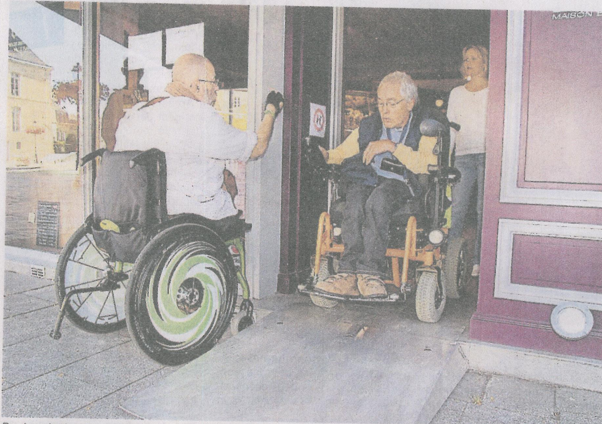
Pas besoin de gros travaux. Une simple rampe amovible et une sonnette permettent de rendre un commerce accessible.
